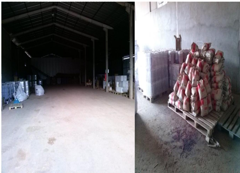
Figura 39: Galpão de armazenamento dos agrotóxicos.
